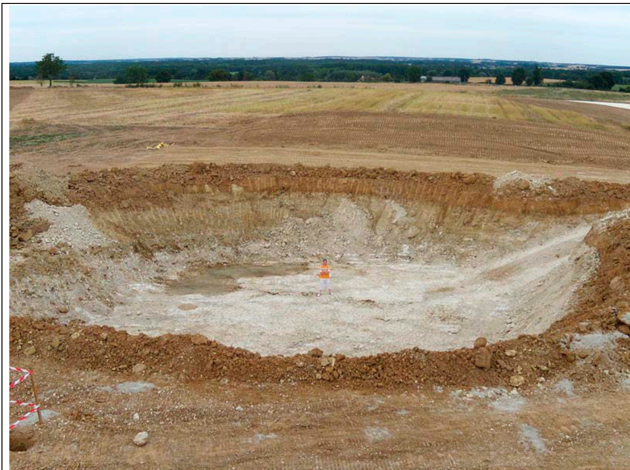
Photo 1 : Création des fouilles de fondations de 18 mètres de diamètre sur 3 m de profondeur, nécessaire à la mise en place d'une éolienne, soit environ 800 à 1200 m 3
